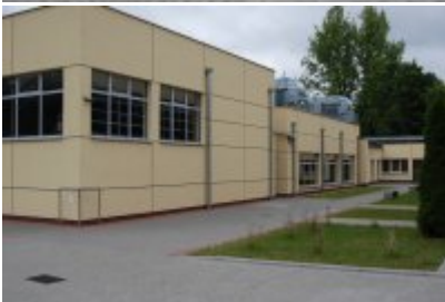
Nowa część budynku hali sportowej
