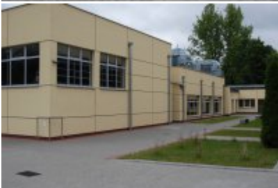
Nowa część budynku hali sportowej
