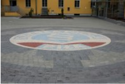
Plac przed obiektami logistyki
