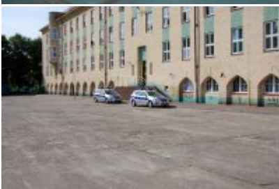
Budynek od strony placu alarmowego
